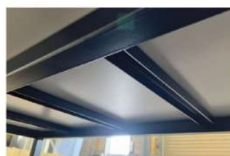
必要強度に合わせて補強します
